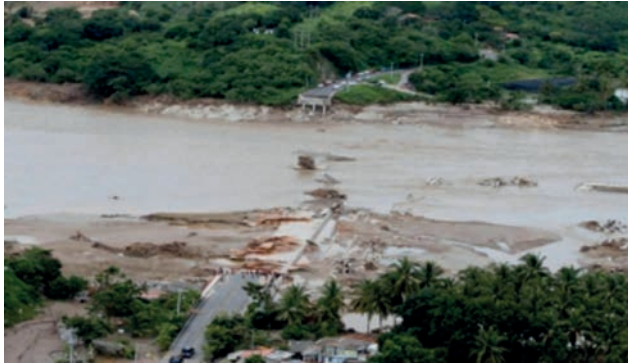
Colapso de un puente sobre el río Papagayo.
